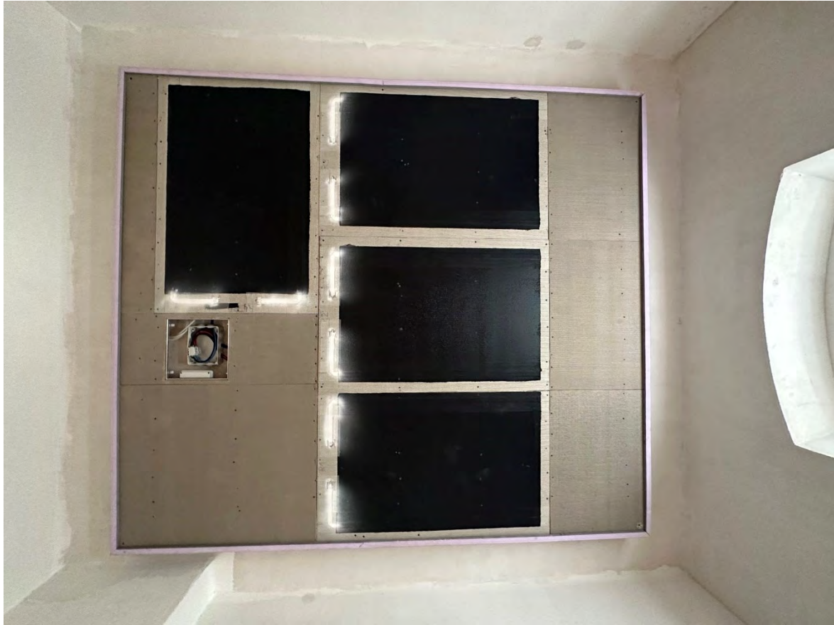
24 Volt Niederspannung, Heizanstrich flächenbündig vormontiert auf unserer Trägerplatte 800 x 1200 x 10mm für den Wand.- und Deckenbereich.
