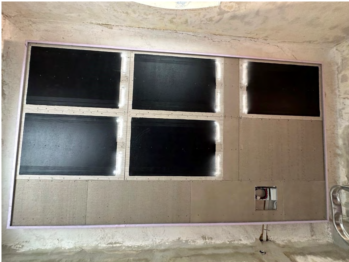
24 Volt Niederspannung, Heizanstrich flächenbündig vormontiert auf unserer Trägerplatte 800 x 1200 x 10mm für den Wand.- und Deckenbereich.
